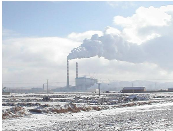
写真 1 B 移民村の隣に建設された火力発電所
